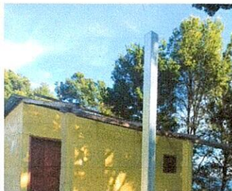
Foto1: Cambio de estructura de madera a metal y cubierta de lámina troquelada calibre 26 del módulo.
