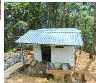
Foto 2: Mejoramiento de paredes en el cambio de cemento, instalación de poyetón, piso, estructura de extracción de humo, cambio de puerta y colocación de balcón.
