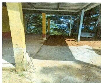
Foto 3: Cambio de pilares, estructura de techo madera a metal y cubierta de lámina troquelada calibre 26 del corredor.
